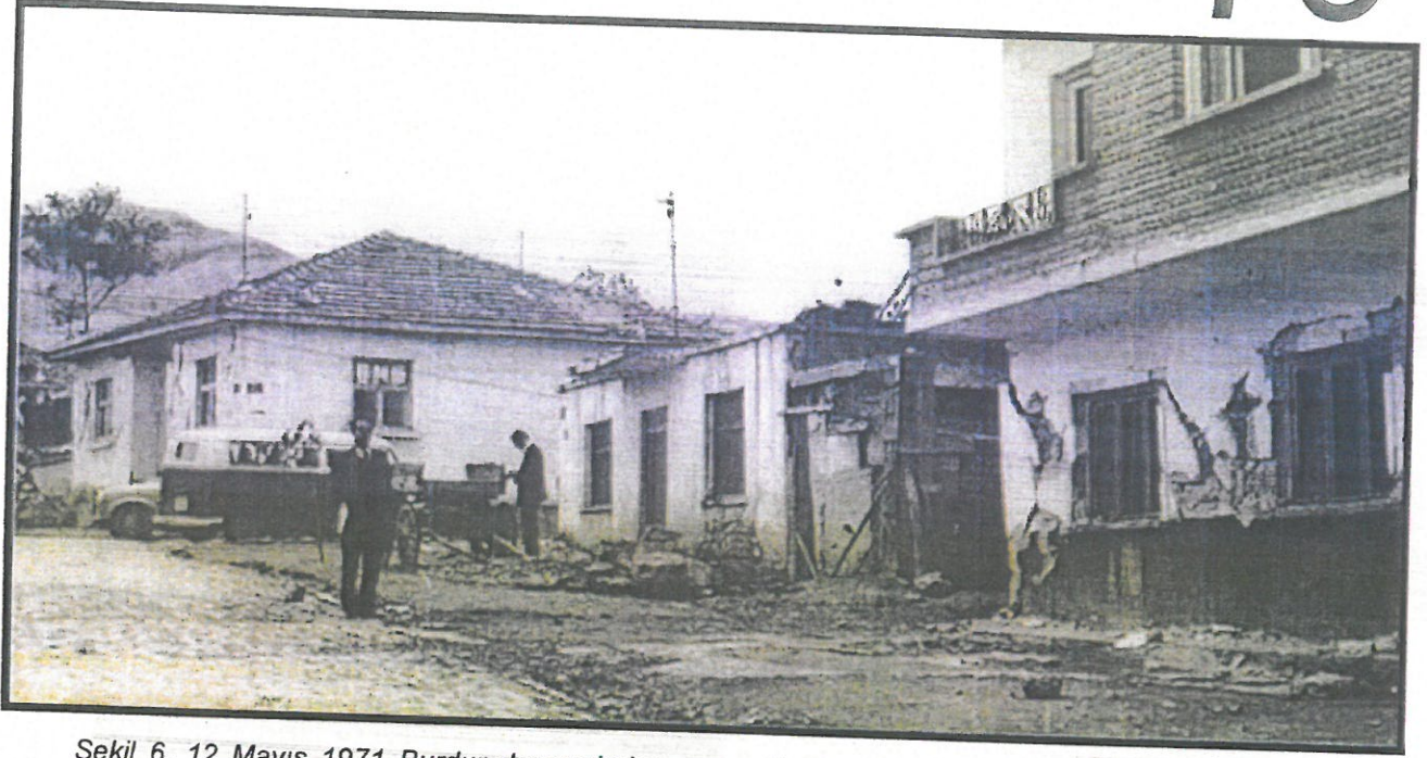
Şekil 6. 12 Mayıs 1971 Burdur depreminden sonra Burdur'da bir sokak. Burdur ve çevresinde gece meydana gelen 6,2 şiddetli depremde 57 kişi öldü, 1.162 ev yıkıldı.
